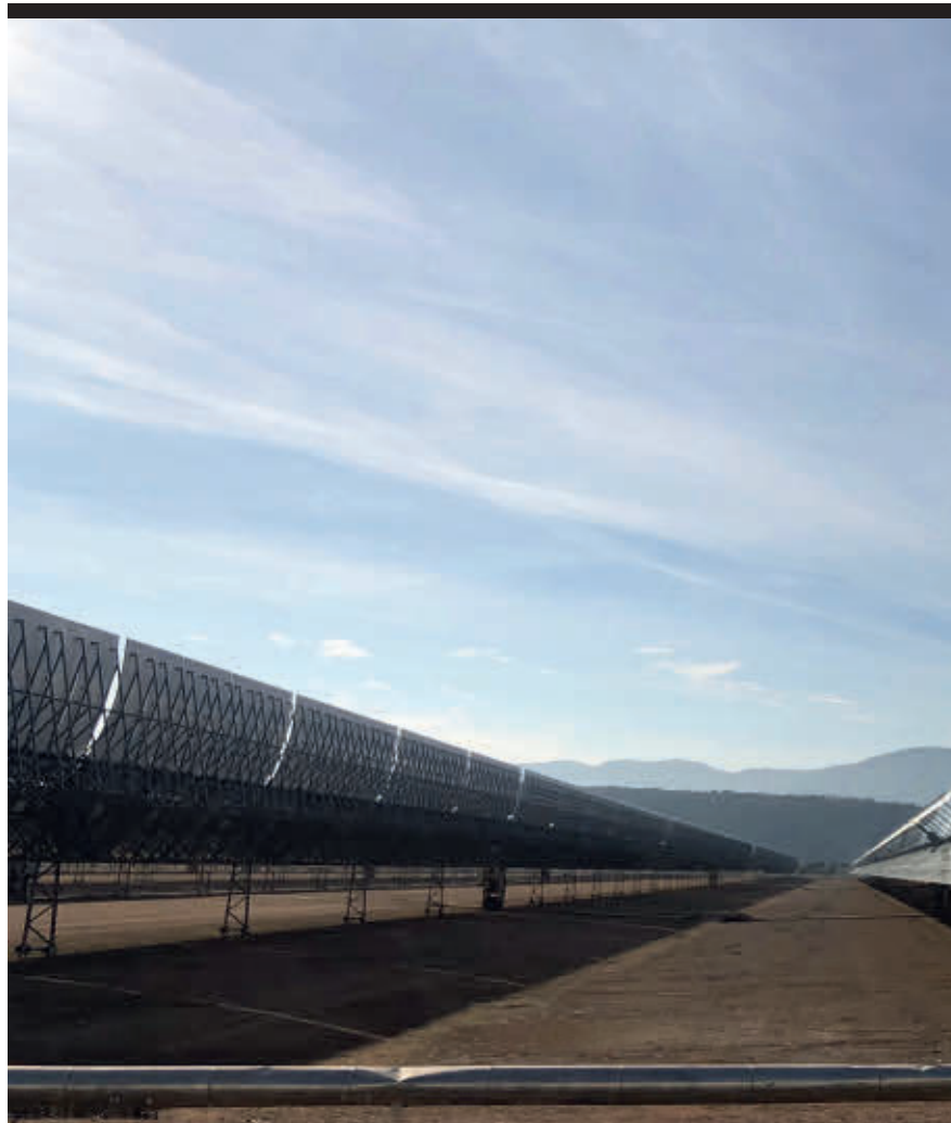
Arriba, la planta termosolar 50 MW Termollano. Abajo, la construcción de la planta Biomasa 50 MW Biollano.
