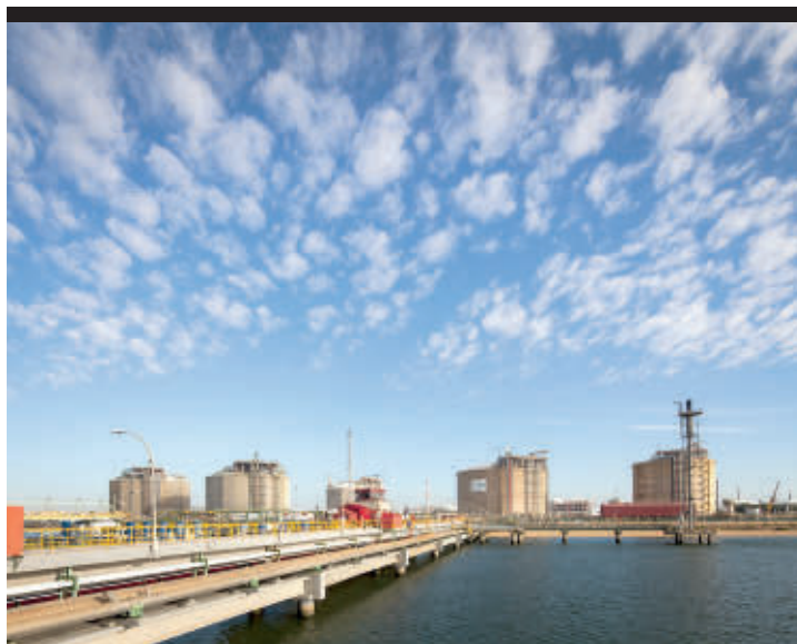
Arriba, planta de Enagás en Huelva. Abajo, señalización de gasoductos.
